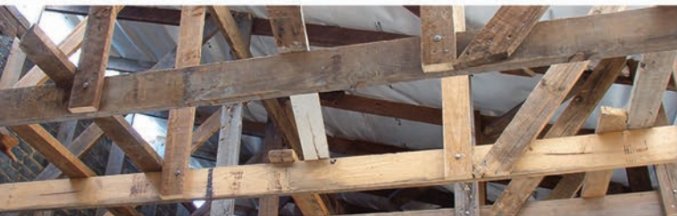
DAKKAPPE OP TERREIN GEBOU
